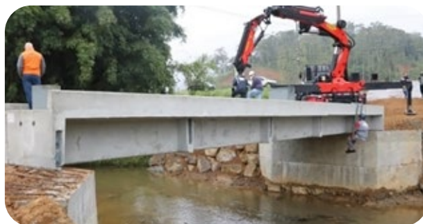
Instalação de kit de transposição de concreto Foto: ASCOM/SDC
