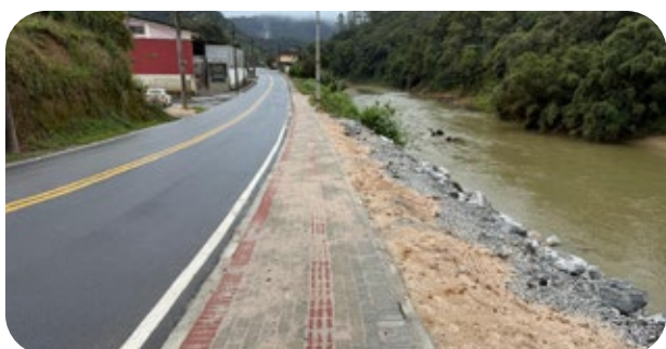
Obra Emergencial na Rodovia SC-486 em Botuverá Foto: Coordenadoria Regional Vale
