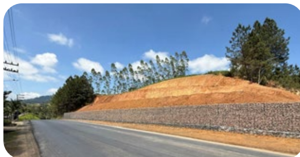
Obra Emergencial na Rodovia SC-340 em Witmarsum Foto: Coordenadoria Regional Vale
