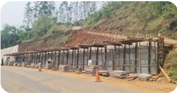
Obra Emergencial na Rodovia SC-370 em Grão-Pará Foto: Coordenadoria Regional Sul
