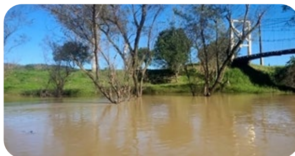
Parte do trecho licitado em Rio do Oeste Foto: ASCOM/SDC
