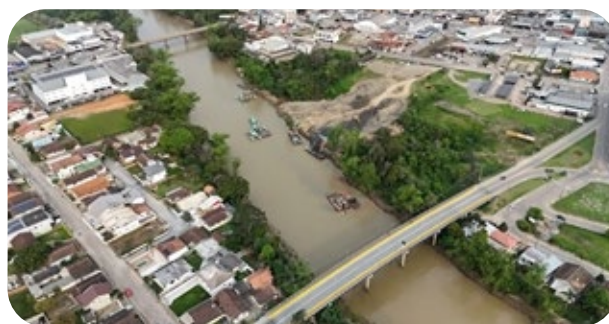
Desassoreamento em trecho urbano de Rio do Sul Foto: ASCOM/SDC
