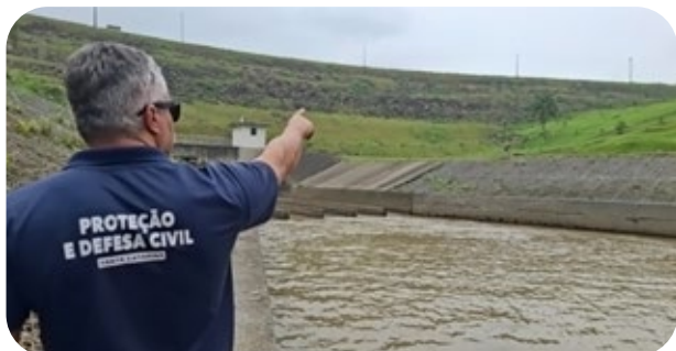
Área a jusante da barragem de contenção de Ituporanga Foto: ASCOM/SDC
