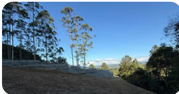
Obra Emergencial na Rodovia SC-340 em Dona Emma Foto: Coordenadoria Regional Vale
