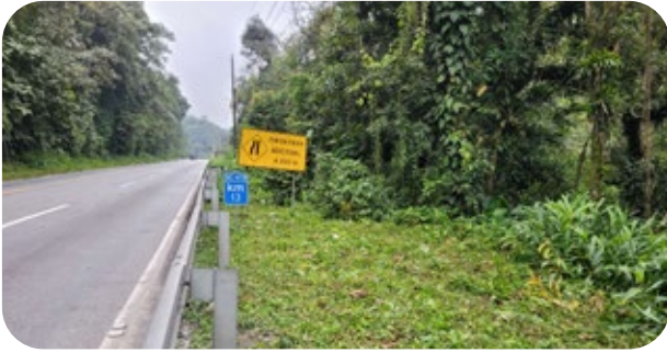
Conservação da Rodovia SC-418 em Joinville. Foto: Coordenadoria Regional Norte
