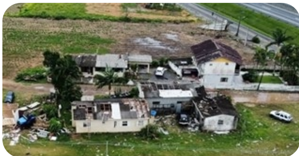
Danos causados por vendaval em Sombrio Foto: ASCOM/SDC
