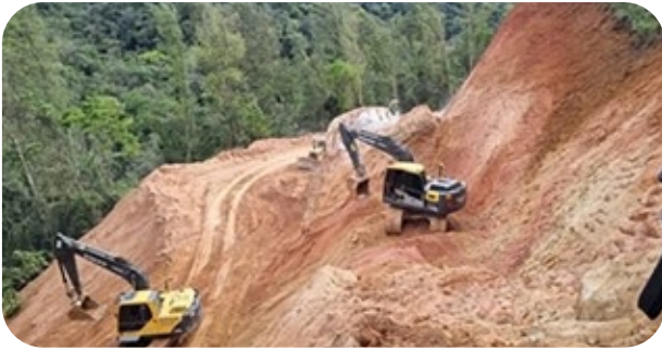
Obra emergencial da Rodovia SC-108 em Angelina Foto: Coordenadoria Regional Litoral Centro
