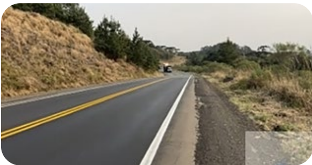
Revitalização da SC-350 em Santa Cecília Foto: Coordenadoria Regional Meio-Oeste
