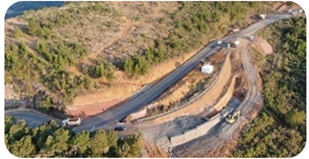
Obra Emergencial na Rodovia SC-110 em Urubici Foto: Coordenadoria Regional Planalto
